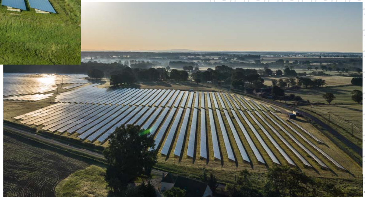
Installation agrivoltaïque de Genettes dans l'Allier
